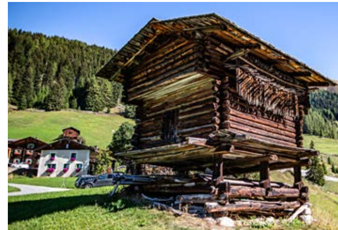
Typisch walsersisch: waghalsig in den Hang gebaute Kornspeicher.
